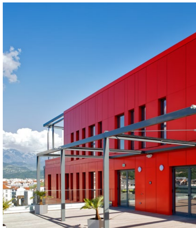
Crédits photos : @ Franck Deletang - Wicona by Hydro Maîtrise d'ouvrage : 6° Sens Immobilier Architecte : Soho Atlas In Fine
